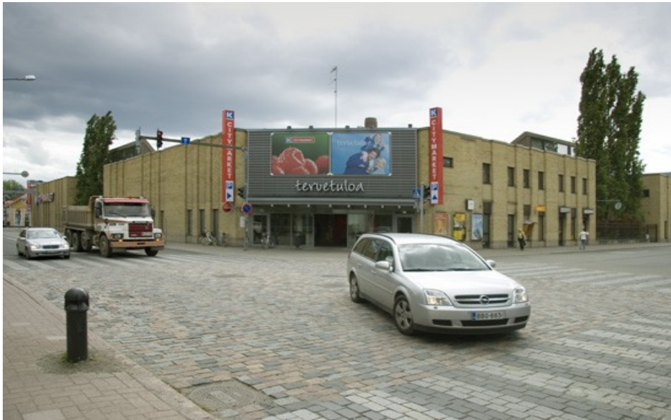
Citymarketin pääsisäänkäyntiä Suvantokadun ja Kauppakadun risteyksessä vuonna 2009.
