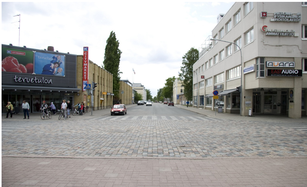
Kaupunkikuvallisesti Citymarketin rakennus ei ole sopusoinnussa yhdenkään naapurirakennuksen kanssa. Kuvassa näkymää Kauppakadulle. Kuva: Pekka Piiparinen
