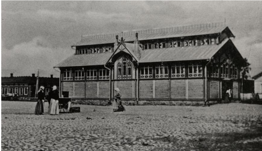
Kauppahalli valmistumisensa jälkeen. Vuonna 1928 halliin lisättiin siipirakennukset. Kuva Pohjois-Karjalan museo
