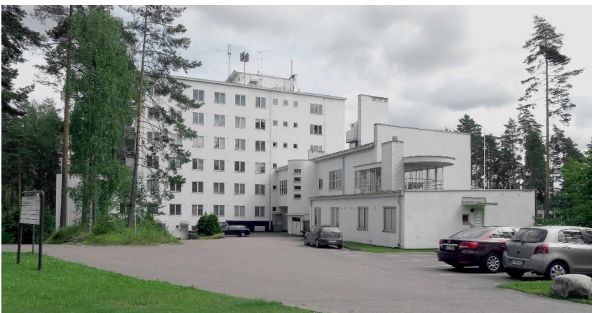
Suomen Urheiluopiston rakennus muodostuu pääasiassa suorakulmaisista massoista, mutta kohteessa on myös 1930-luvun funktionalismille tyypillisiä kaarevia rakennuspintoja. Kuva Pekka Piiparinen, kuvankäsittely Mervi Mäkinen.
